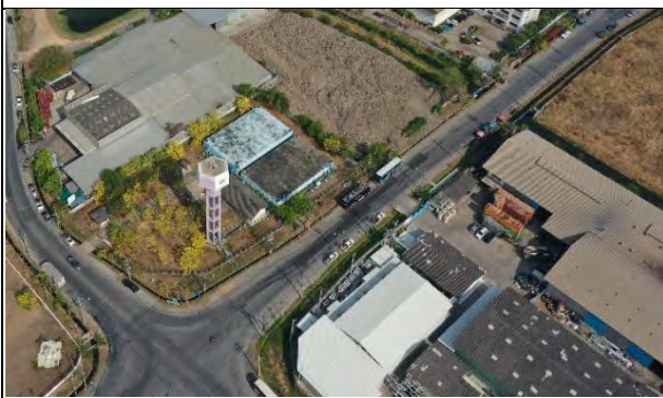
ถังเก็บน้ำประปาและท่อน้ำของโครงการ
