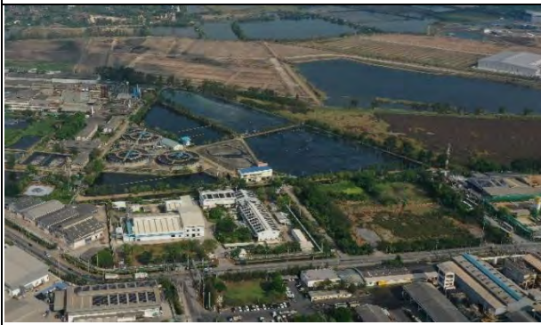
ระบบบำบัดน้ำเสีย แห่งที่ 1
