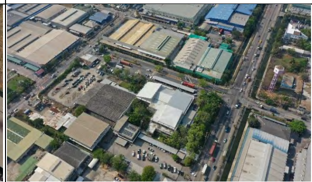
ถนนภายในโครงการ
