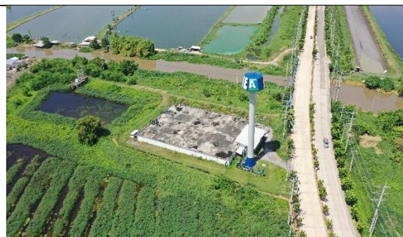
ระบบเก็บและจ่ายน้ำประปาแห่งที่ 2
