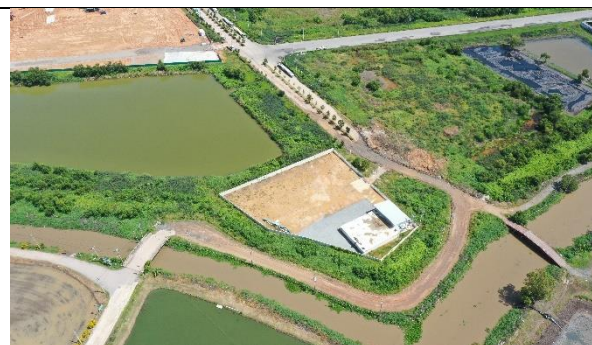
ระบบเก็บและจ่ายน้ำประปาแห่งที่ 3
