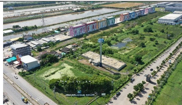
ระบบเก็บและจ่ายน้ำประปาแห่งที่ 1
